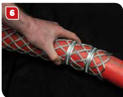
6 Når kabelgrepet er på plass, skal begge klemmene festes til enden av grepet (som vist). Vi anbefaler mellom 30 og 50mm unna enden av kabelgrepet.
