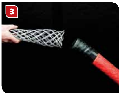
3 Grepet skal deretter plasseres over...
