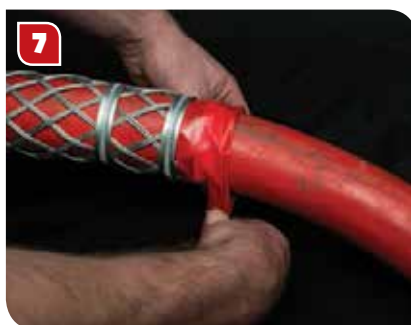
7 PVC-teip bør deretter vikles rundt enden av kabelgrepet lengst bort fra øyeendene.
