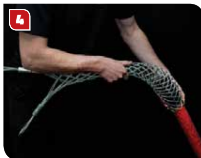
4 ...og føres over enden av kabelen.
